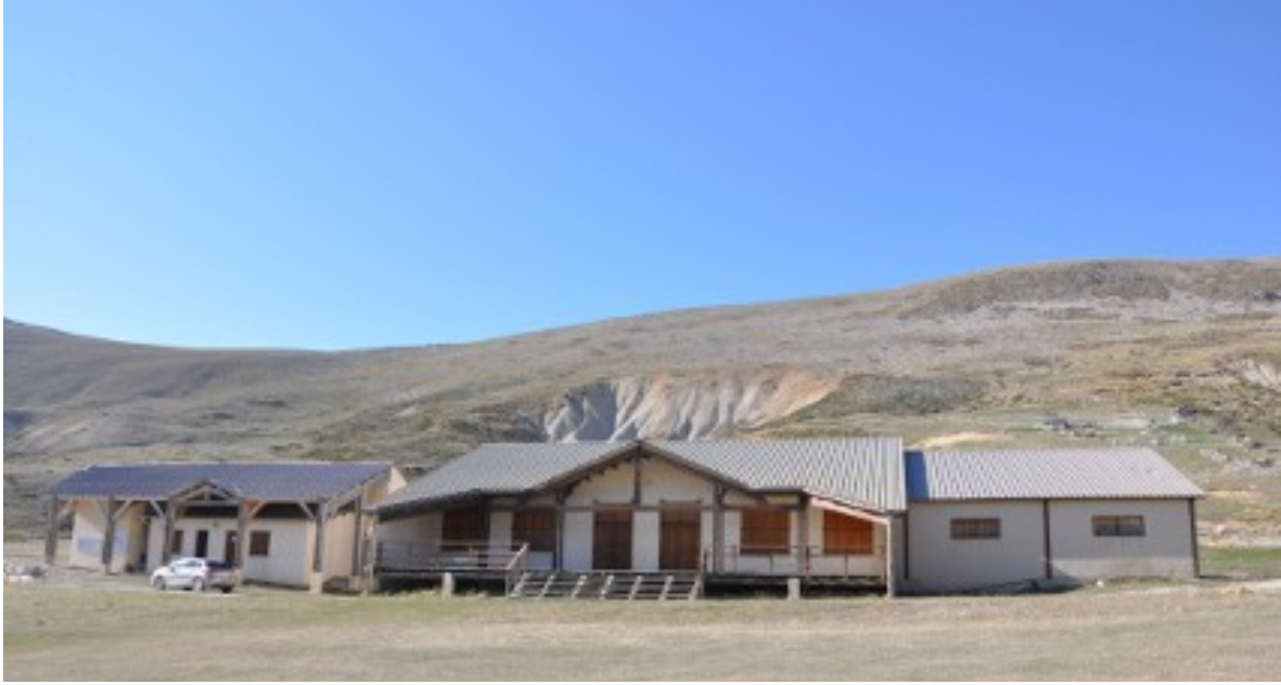
Bâtiments existants, façades sud. Photo M. Douarce atm
