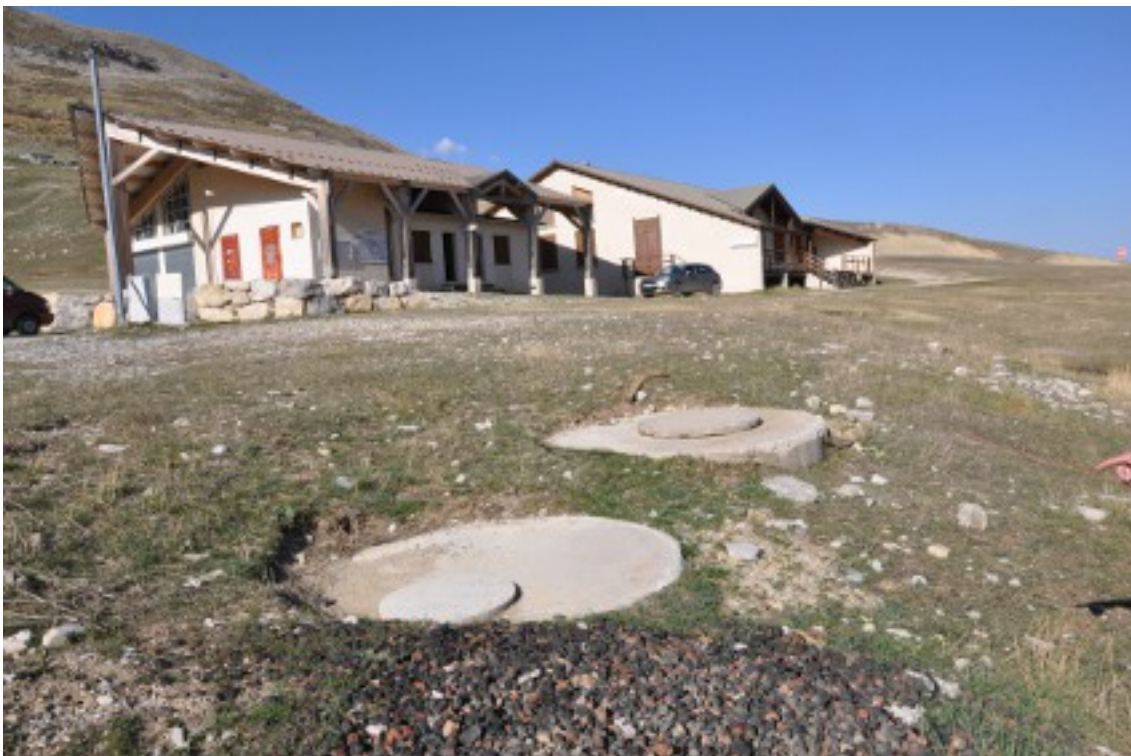
Assainissement : fosse septique. Photo M. Douarche atm
