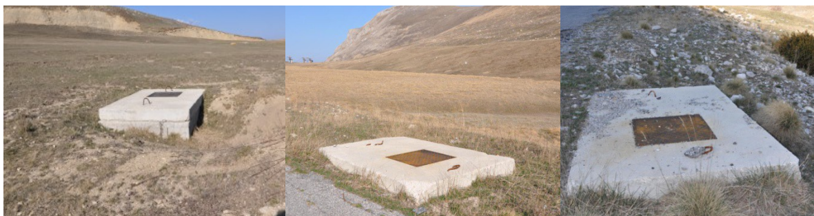
Les trois forages. Photos M. Douarche atm
